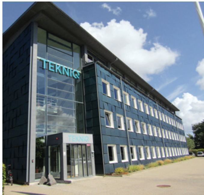
Facaden efter udskiftning af vinduer. Foto: Tekniq
