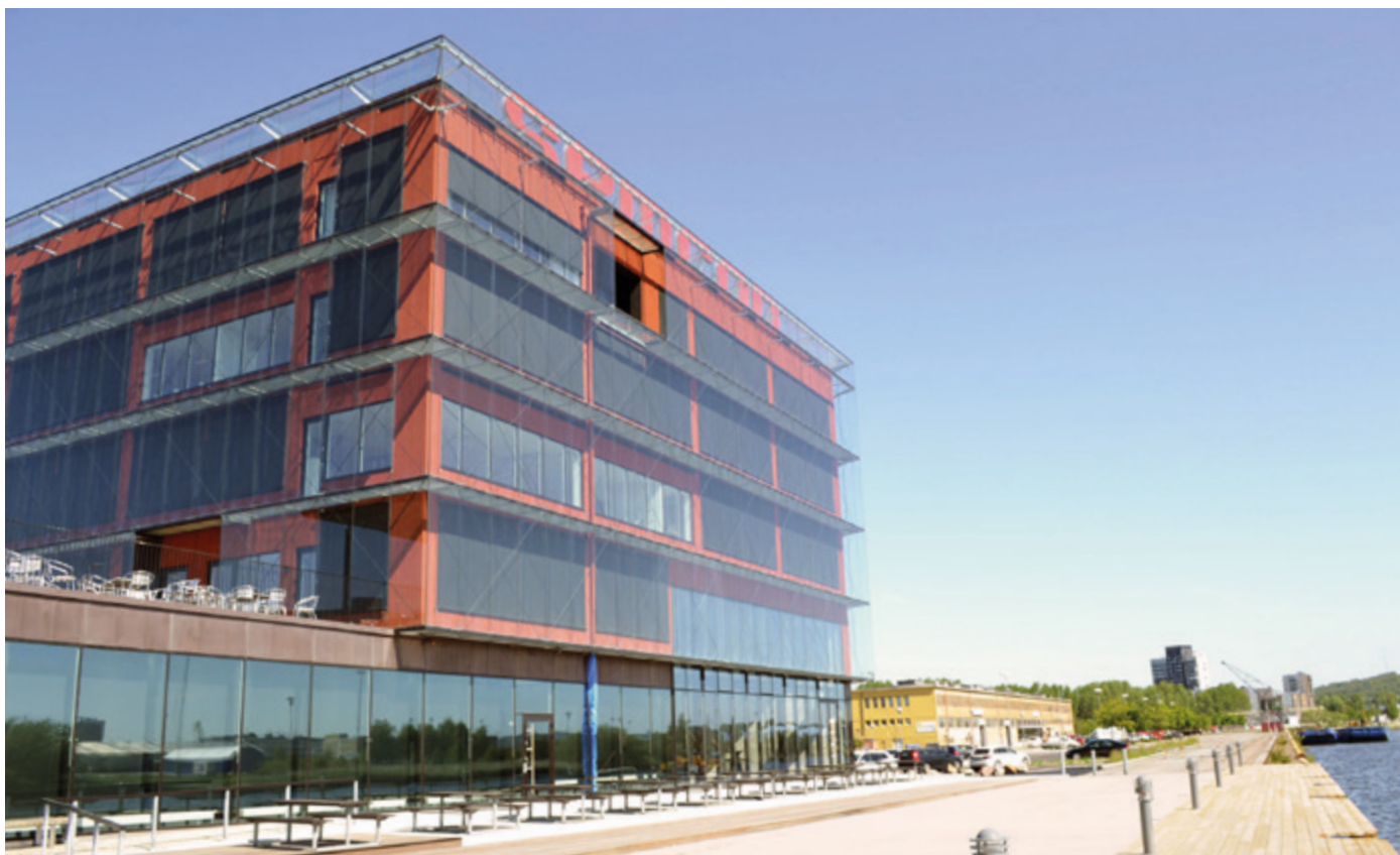
Screen i dobbeltfacade på Semcon i Göteborg. ACC Glas och Fasadkonsult.
