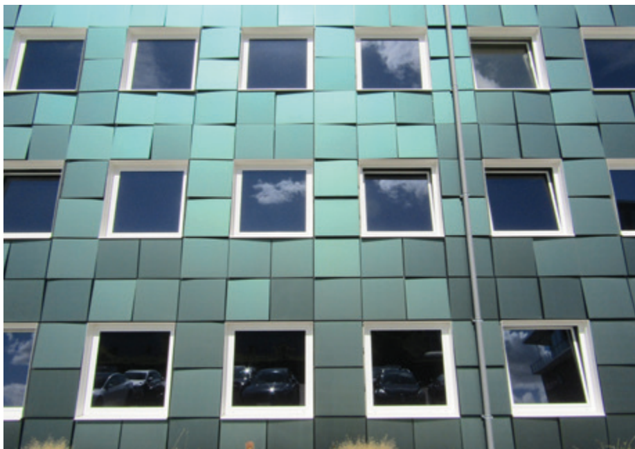
Sydfacaden med dynamiske glas i vinduerne og grønne solceller, der dækker resten af facaden.
